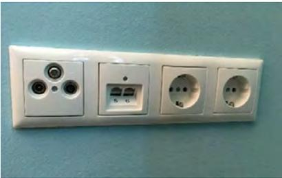
Abbildung 54: Mögliche Konfiguration von Wandauslässen (Koax, Daten und Strom) (Quelle: DT)
