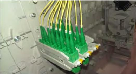
Abbildung 39: Beispiel einer übersichtlichen Steckerablage im Glasfaser-Gebäudeverteiler (Gf-GV) (Quelle: DT)
